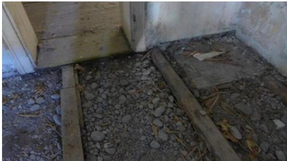
Bild 4: Typische Holzbalkendecke des unsanierten Hauses mit Kiesbeschwerung aus dem nahen Lech.
