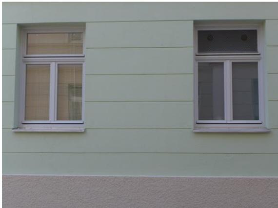
Bild 7: Details des sanierten Hauses: Das rechte Fenster hat im Oberlicht den Ein- und Auslass der Lüftungsanlage, verdeckt mit einer grauen Lochplatte. Fenster links mit Glasoberlicht.
