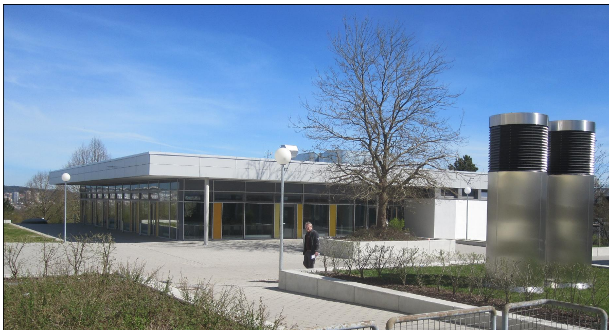
Bild 2: Der Neubau der Mensa in Ulm. © Foto: Stadt Ulm, Zentrales Gebäudemanagement, Energiemanagement
