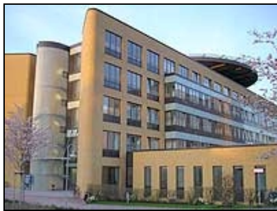
Neubau des Neurozentrums, Universitätsklinikum Kiel. Foto: tha - Ingenieurbüro Eßmann
