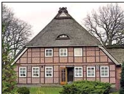
Sanierung eines Fachwerkhouses in Winsen-Luhdorf. Foto: tha - Ingenieurbüro Eßmann
