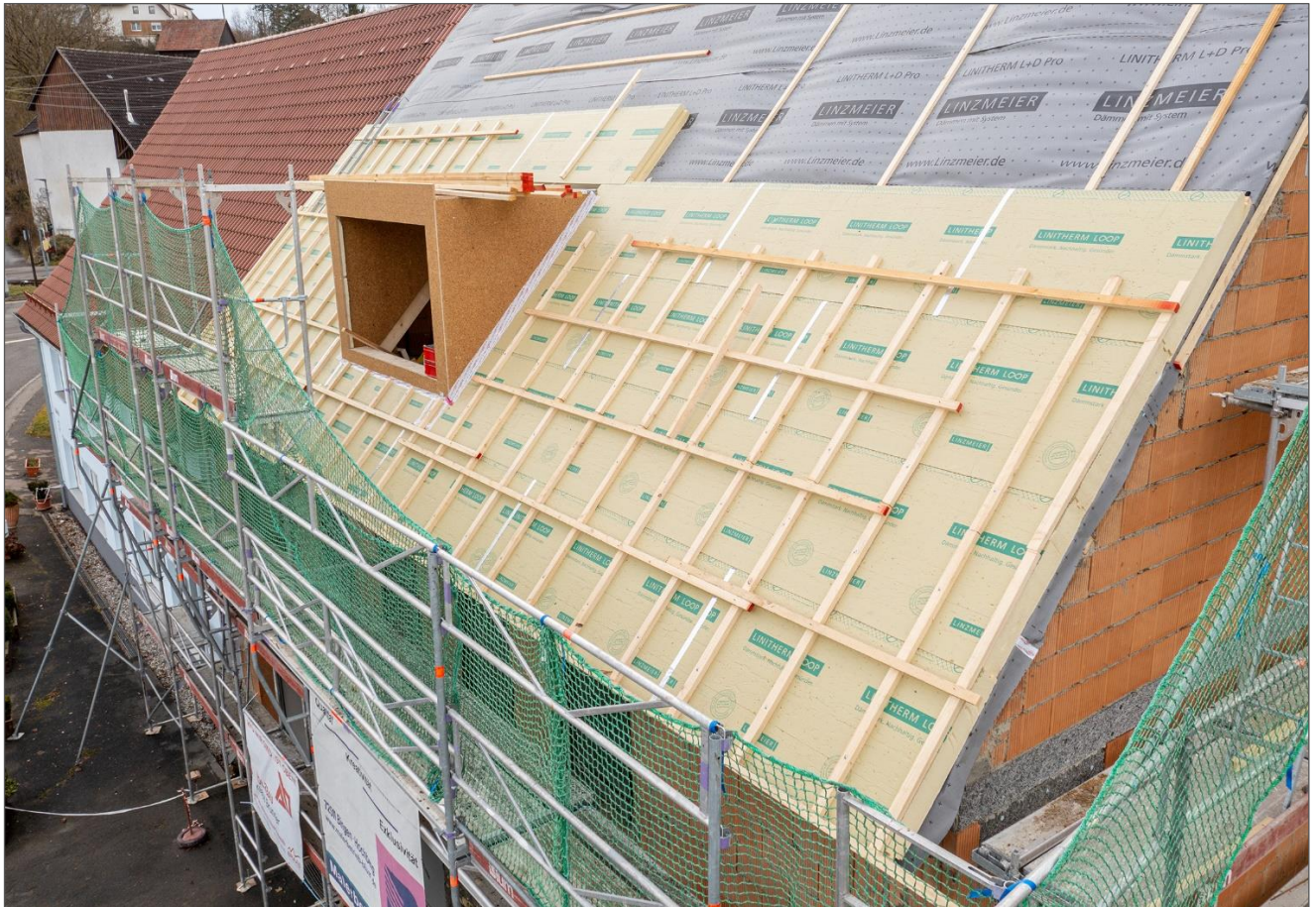
Bild 3: Die Aufsparrendämmung Linitherm Loop Pals N+F ermöglicht schlanke Bauteilaufbauten. © Linzmeier
