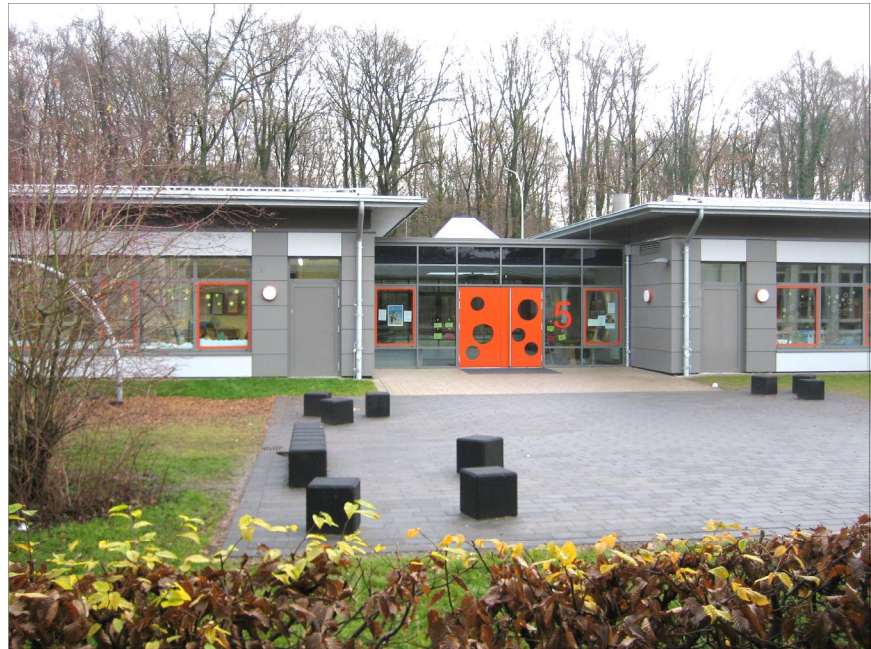
Bild 3: Der Eingangsbereich der Overberg-Gundsche in Paderborn. © Foto: e&u energiebüro
