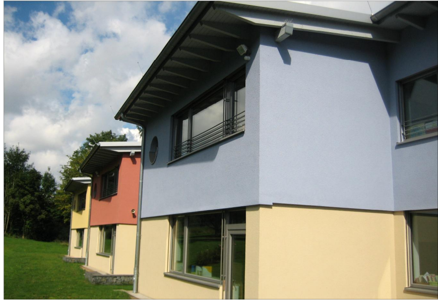
Bild 2: Die Klassentrakte der Förderschule Bega im Kreis Lippe. Foto: e&u energiebüro
