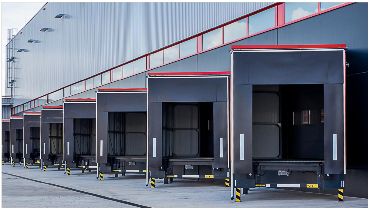
Bild 3: Beispielhafte Logistik-Immobilie mit den Liefer-Ausgängen.
