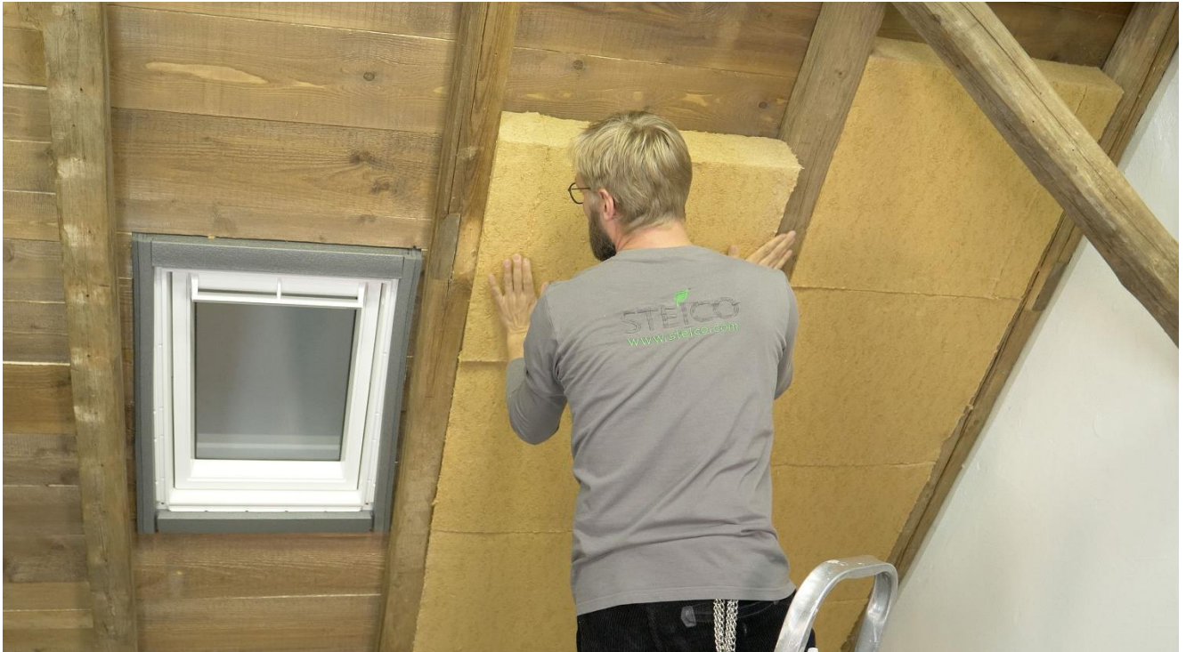
Abb. 2: Energetischen Modernisierung eines Bestandsdachstuhls von innen mit der Holzfaser-Dämmmatte STEICOflex 036 als Zwischensparrendämmung. © Foto: STEICO
