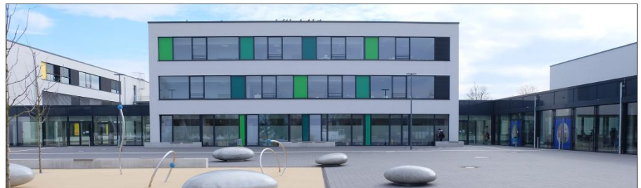
Bild 6 und 7: Das größte Passivhaus-Projekt in Niedersachsen: Neubau der Leonore-Goldschmidt-Schule in Hannover-Mühlenberg für 2.000 Schüler und Lehrer. © Foto: Unverzagt
