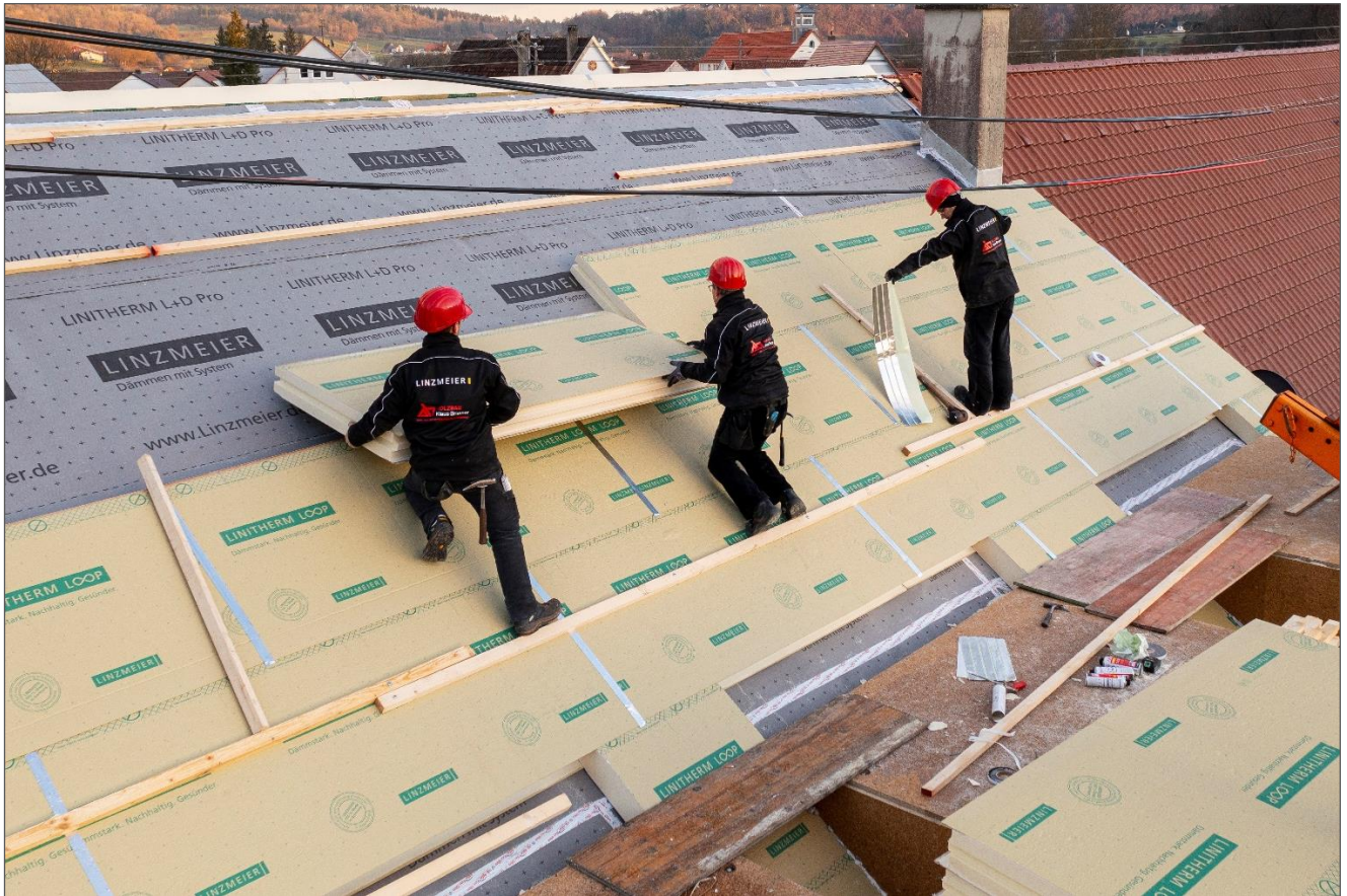
Bild 2: Im neuen Produkt Linitherm Loop sind über 60 Prozent der PU-Rohstoffe biobasiert. © Foto: Linzmeier
