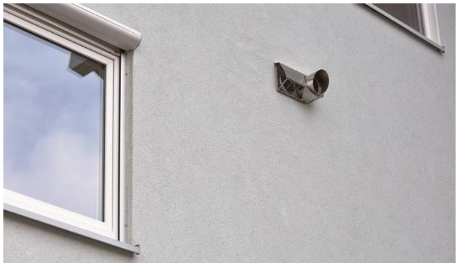
Abb. 4: Die neue Lüftungsnorm DIN 1946-6 enthält Anhaltswerte für die Mindest-Abstandsmaße zwischen Außen- und Fortluftdurchlässen. Sollte der Abstand einmal nicht eingehalten werden können, kann das Zehnder Kombi-Außenwandgitter verwendet werden, welches beide Durchlässe in einem kompakten Bauteil vereint, aber clever aneinander vorbeiführt.
