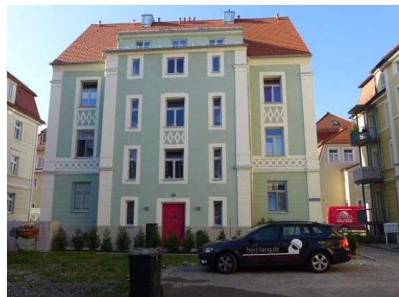
Bild 1: Die Ostfassade des denkmalgeschützten Mehrfamilienwohnhauses saniert und nach alten Mustern gestrichen.
