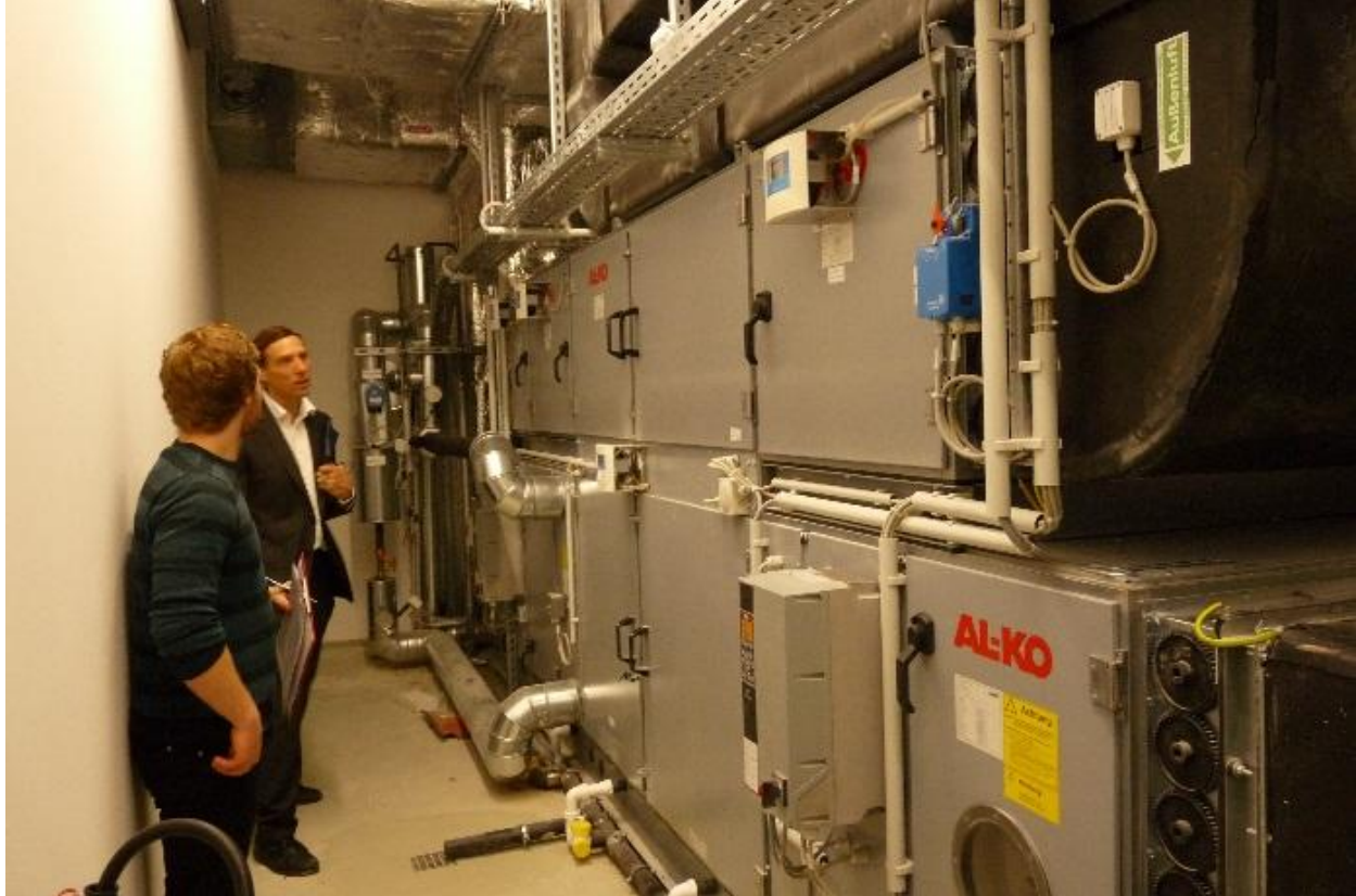
Bild 7: Dr. Kuckelkorn und einer seiner Mitarbeiter bei Überprüfung des Betriebs der Lüftungsanlagen. Abgebildet ist hier die RLT-Anlage mit Wärmerückgewinnung für den Küchenbereich.
