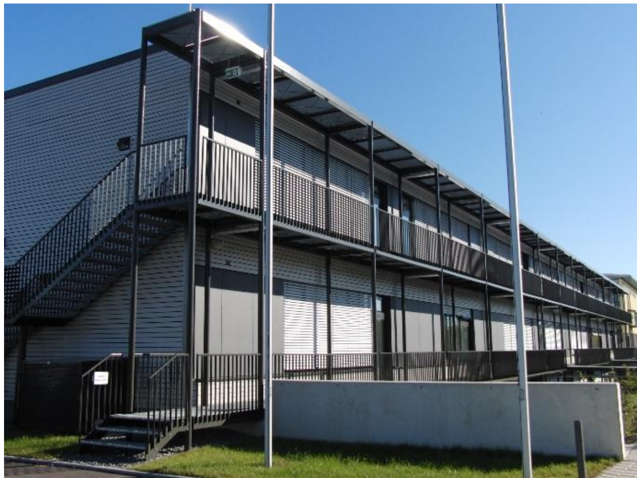
Bild 1: Ansicht der Südfassade mit aktivierter Verschattungsanlage im Sommer. Vor den Fensterbändern sind vorgelagerte Fluchtbalkone angeordnet, die Lamellenbehänge der außenliegenden Verschattung werden im Cut-Off-Winkel betrieben und können manuell übersteuert werden.
