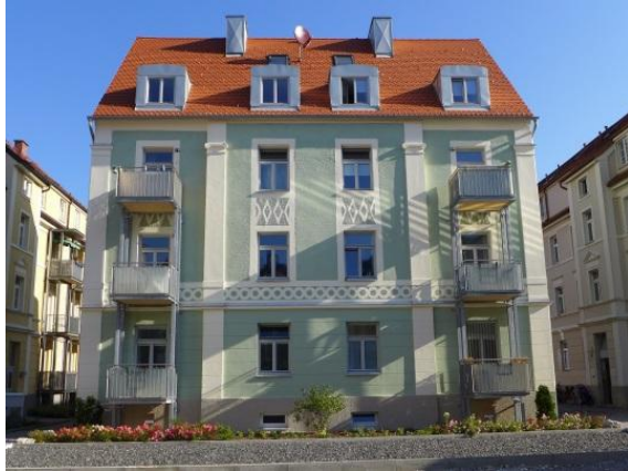
Bild 5: Die Fassade des denkmalgeschützten Hauses saniert, neu gestrichen und mit Balkonen nach Westen aufgewertet.
