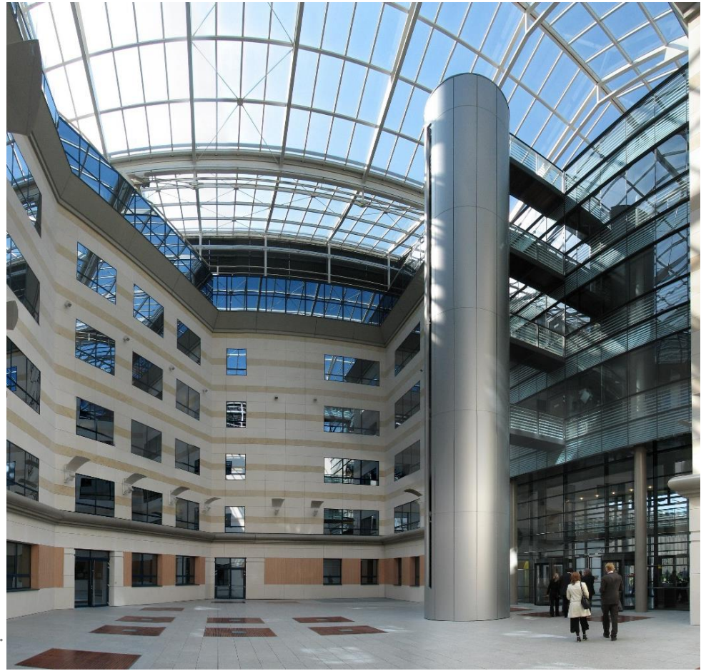
Abb. 4: Moderne Nichtwohngebäude sparen durch Automation erhebliche Energiemengen. © olexa - Fotolia.com
