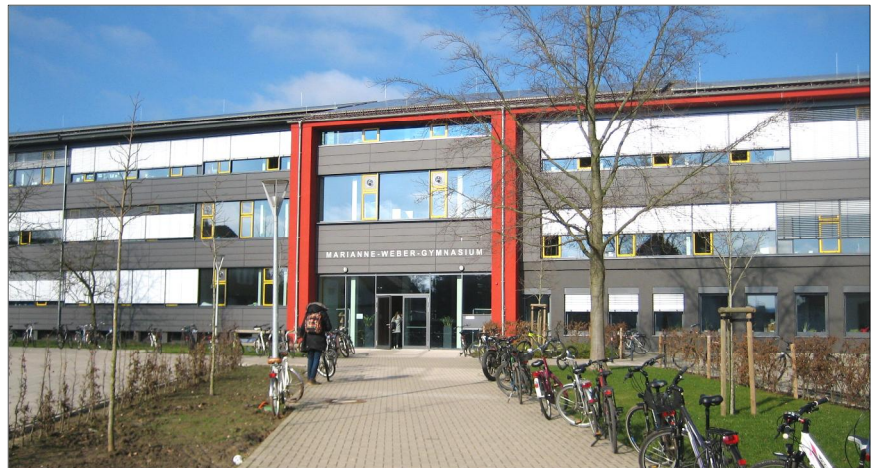
Bild 4: Eingangsbereich des Marianne-Weber-Gymnasiums in Lemgo. © Foto: e&u energiebüro
