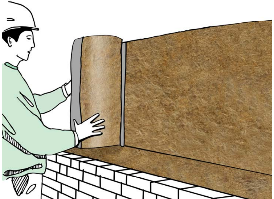
Bild 6: Für die Dämmung eines zweischaligen Mauerwerks im Neubau empfiehlt es sich, Platten oder Rollen aus Mineralwolle zu verwenden. © Foto: FMI
