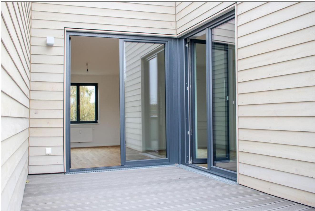
Abbildung 3: Die Sanierung des Wohnriegels aus den 1960er Jahren mit nachhaltigen Baustoffen wie Holz und Mineralwolle. © Foto: Kantstein Architekten
