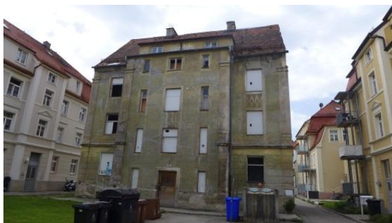
2. Bild: Bestandsgebäude der ehemaligen Arbeiterwohnsiedlung der Hanfwerke Füssen-Immenstadt Ostseite. Letztes unsaniertes Gebäude, nahe dem Stadtzentrum.
