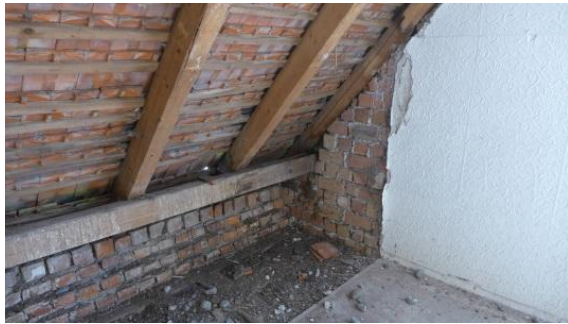
Bild 3: Guter Zustand des Daches, des Kniestocks und der Holzbalkendecke des Hauses vor der Sanierung.
