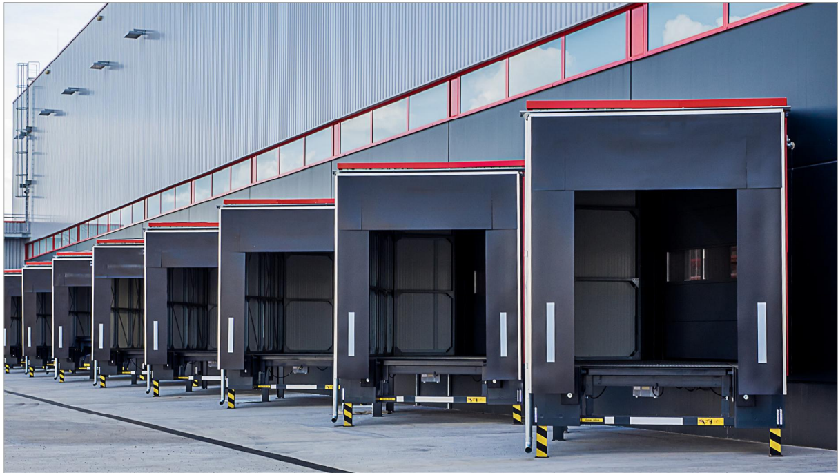
Bild 3: Beispielhafte Logistik-Immobilie mit den Liefer-Ausgängen.
