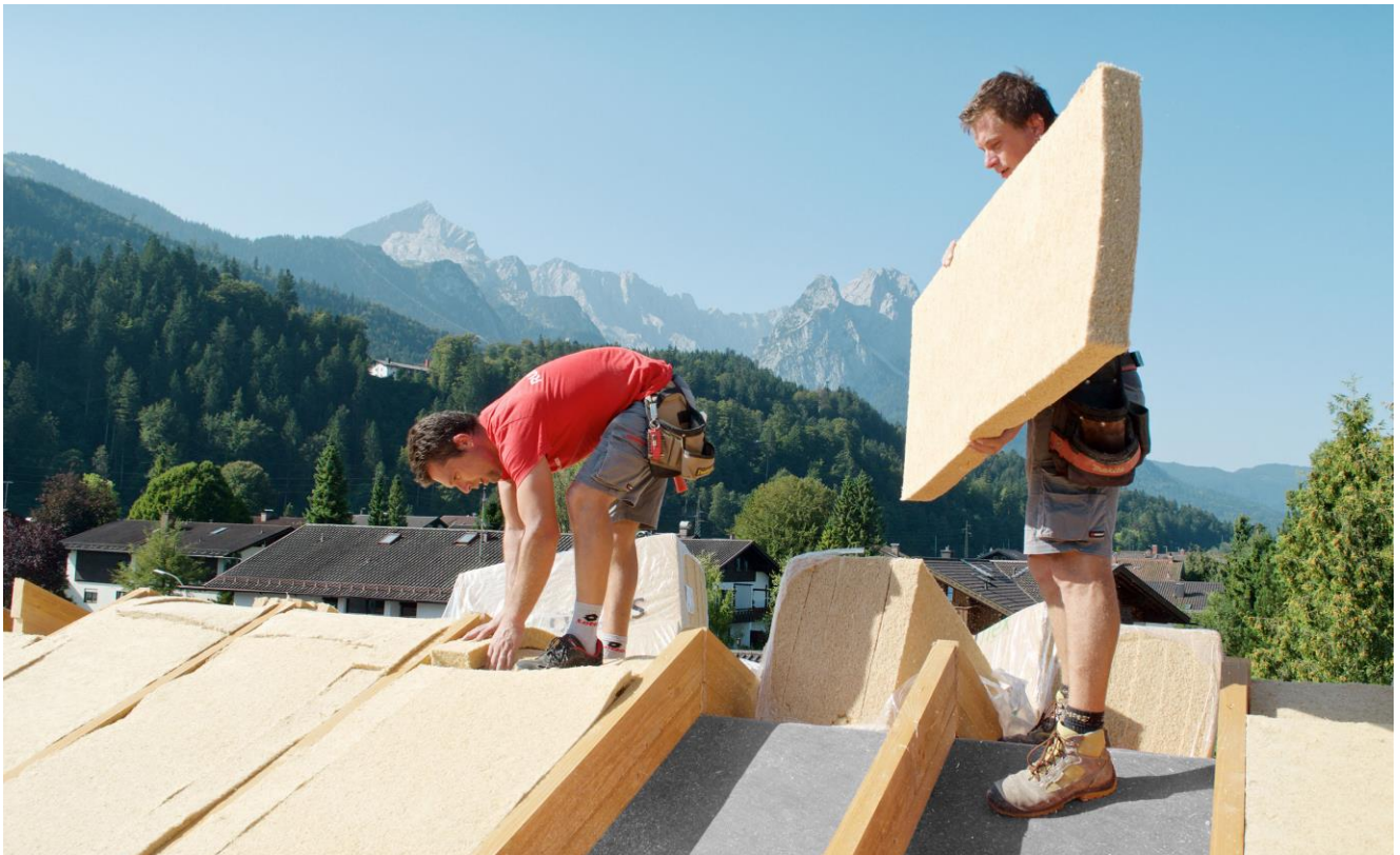
Abb. 3: Dämmung eines Neubaus von außen mit der Holzfaser-Dämmmatte STEICOflex 036 als Zwischensparrendämmung. © Foto: STEICO
