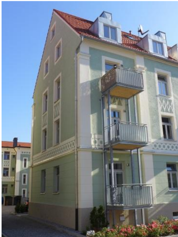
Bild 8: Blick auf den sanierten Baukörper mit den neuen Balkonen an der Westfassade.
