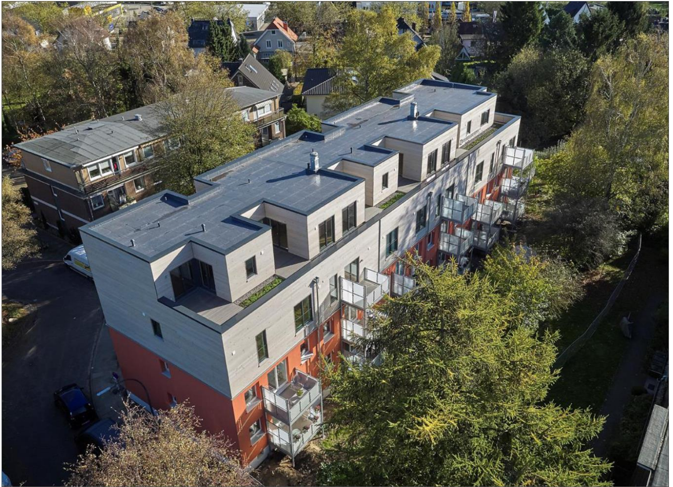
Abbildung 2: Die Sanierung des Wohnriegels aus den 1960er Jahren schafft nachhaltig mit Holz und Mineralwolle gut nutzbare Fläche im dichten, urbanen Hamburger Raum. Dafür gab es eine Anerkennung beim Holzbaupreis 2020.
