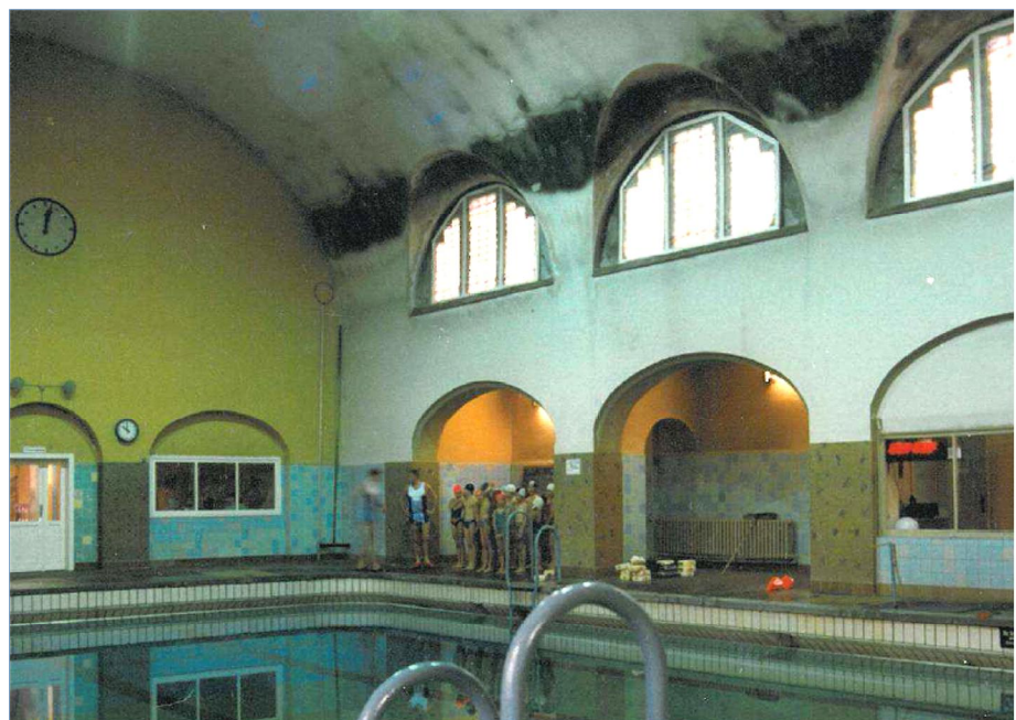
Bild 1: 1996: Bauphysikalische Verhältnisse in einem denkmalgeschütztem Schwimmbad. © Foto: Unverzagt
