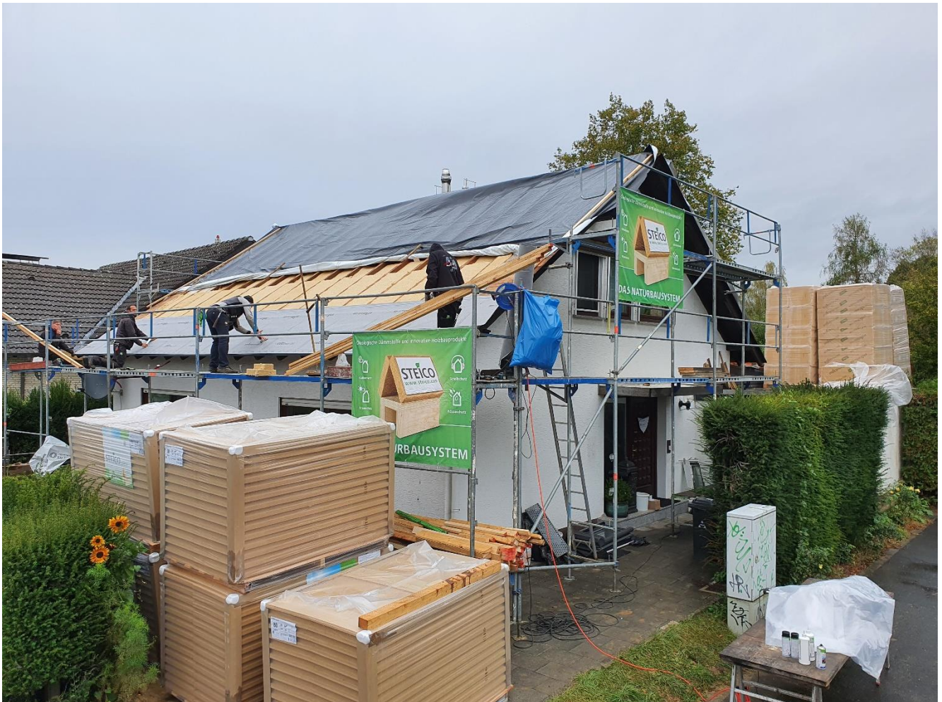
Abb. 4: Energetische Dachmodernisierung eines Einfamilienhauses von außen, ebenfalls mit der STEICOflex 036 als Zwischensparrendämmung. © Foto: STEICO
