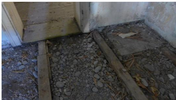
Bild 4: Typische Holzbalkendecke des unsanierten Hauses mit Kiesbeschwerung aus dem nahen Lech.
