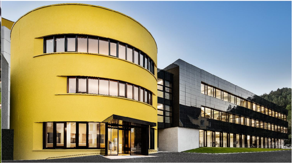
Bild 3: Das neue Empfangs- und Bürogebäude in der Sto-Firmenzentrale in Stühlingen erfüllt den Standard eines Nullenergie-Neubaus.
