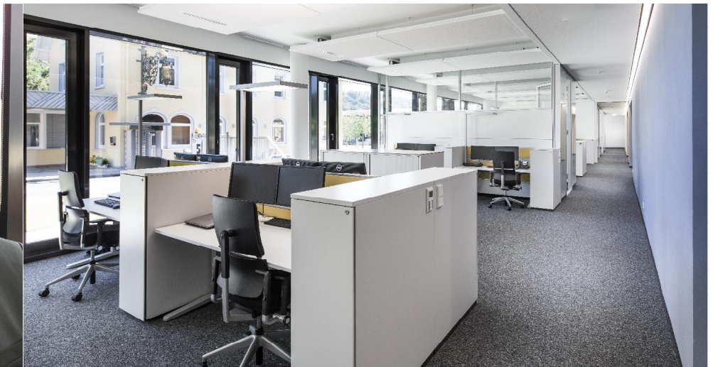
Bild 7: Die Akustik in den Bürolandschaften wird durch schallabsorbierende Akustikdecken und Akustikdeckensegel optimiert.
