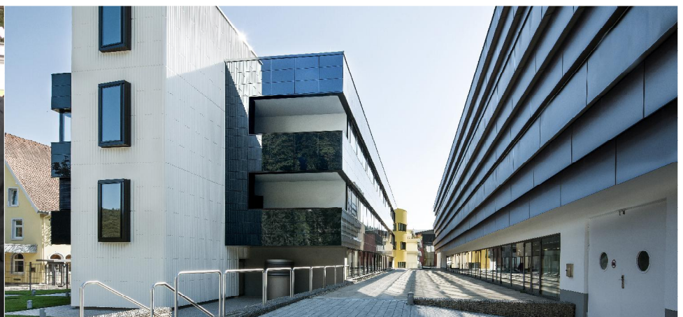
Bild 5: Auf der Rückseite verläuft der Gebäuderiegel parallel zur 2003 errichteten „Just-in-Time-Produktion“.
