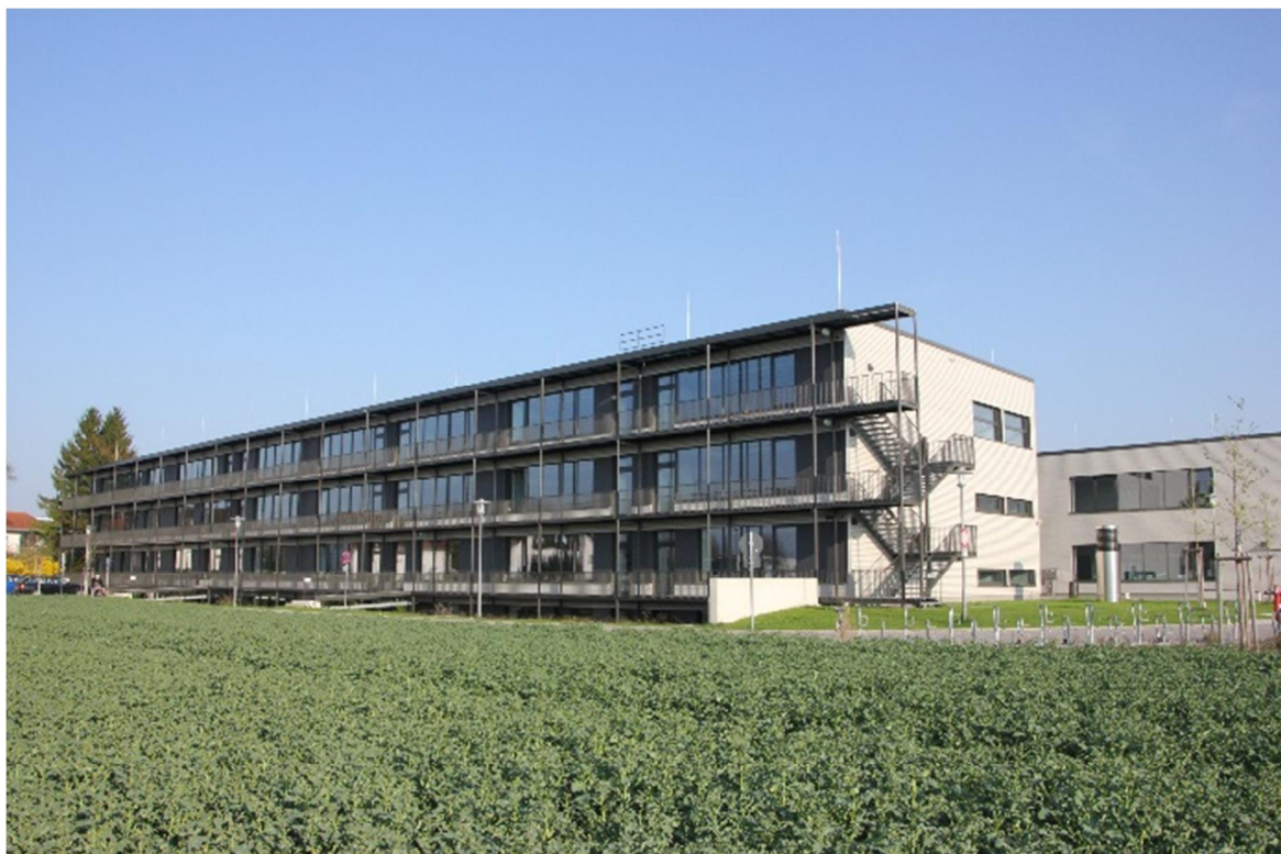
Bild 2: Ansicht der Nordfassade. Der Nordriegel verfügt über vier Stockwerke, davon ein Untergeschoss. Auch hier sind vor den Fensterbändern die vorgelagerten Fluchtbalkone angeordnet. Am rechten Bildrand ist der leicht nach Westen versetzte Südriegel mit drei Stockwerken zu erkennen.
