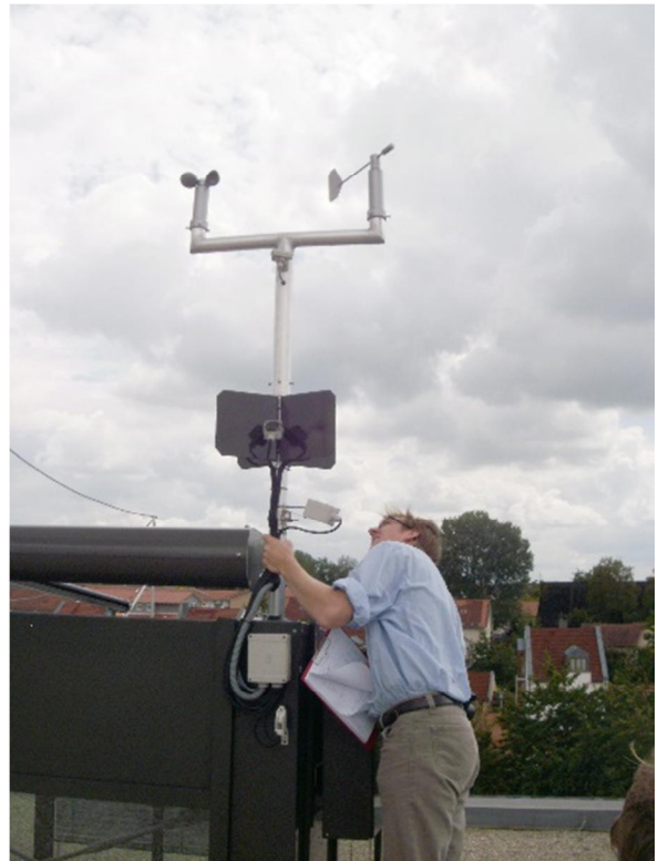
Bild 9: Ein Mitarbeiter des ZAE Bayern bei der Inspektion der Wetersensorik auf dem Dach des Gebäudes. Insgesamt wurden über 850 Datenpunkte verifiziert und im Minutentakt jahrelang aufgezeichnet.
