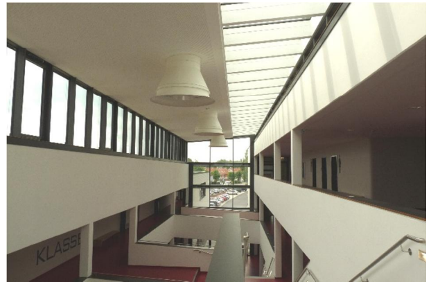
Bild 3: Innenansicht des Atriums. Bei der kompakten Bauweise verbindet das Atrium in der Mitte den Nord- und den Südflügel. Zu erkennen ist ein reduzierter Fensteranteil und an der Decke die Abluftventilation zur Gebäudekühlung durch Nachtlüftung. © Foto: ZAE Bayern
